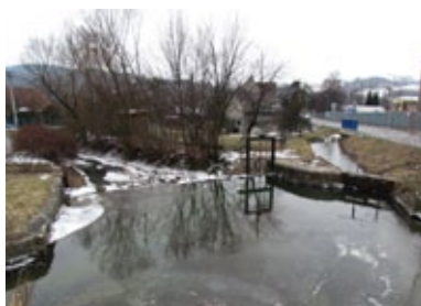
Ve městě Zubří je voda strouhy zachycená nad jezem na Zuberském potoce, odkud je propustí (vpravo) vypouštěna do pokračování strouhy, která protéká areálem továrny Gumárny Zubří a dál pokračuje k Hamerským rybníkům. V prostoru Gumáren stával původně moučný mlýn.
