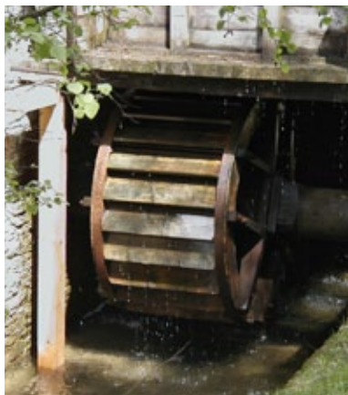
V Mlýnské dolině Valašského muzea v přírodě uvádí voda strouhy do pohybu vodní kolo moučnického mlýna.
